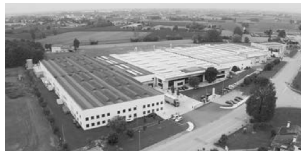
Unit 2: Nicos International Prata di Pordenone - Centro logistico e sito produttivo di solid surface 20.000 mq Nicos International Prata di Pordenone unit - Logistic center and solid surface factory 20.000 sqm
