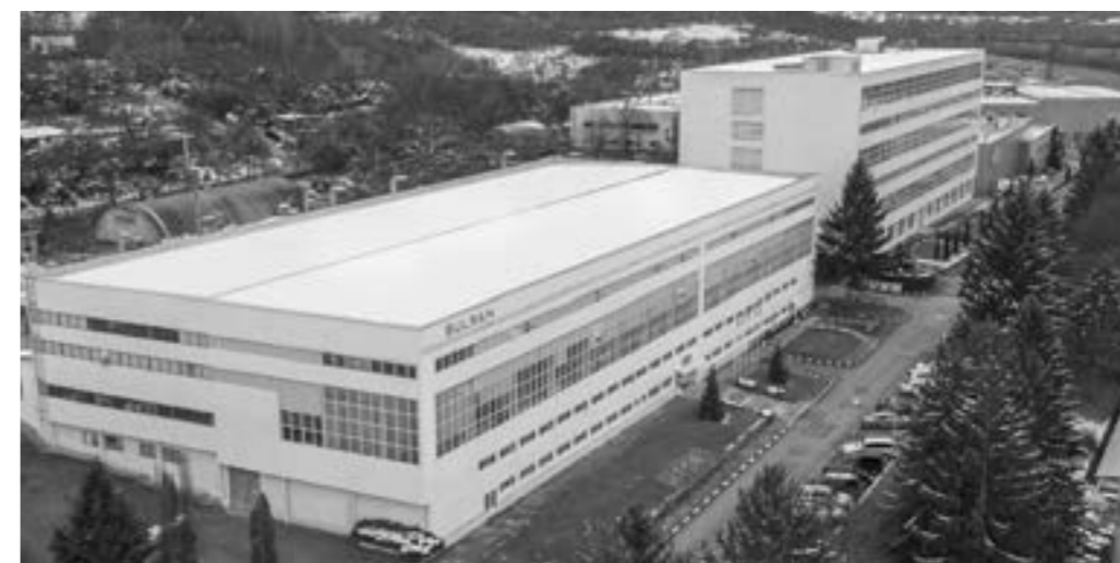
Bulsan Eood Botevgrad Bulgaria - Sito produttivo di cast marble 18.600 mq Bulsan Eood Botevgrad Bulgaria - Cast marble factory 18.600 sqm
